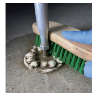
床束に溜まった汚泥をブラシで掻き出している様子
