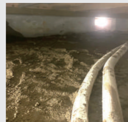
防湿シート撤去後
