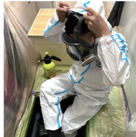
防護服を着用して床下の消毒に入る様子
