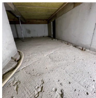
バイオ洗浄（微生物）の力によって、カビで変色したコンクリート面は綺麗に再生。
