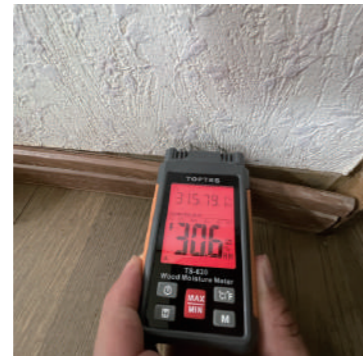
石膏ボードの含水率調査
