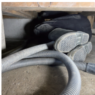
床下の復旧作業
