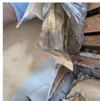
濡れてる断熱材の撤去
