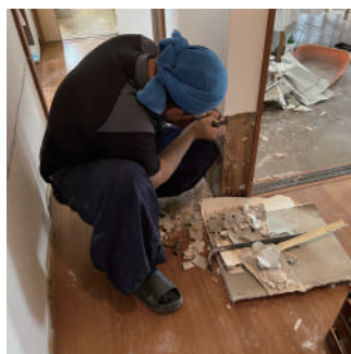
浸水部の解体
